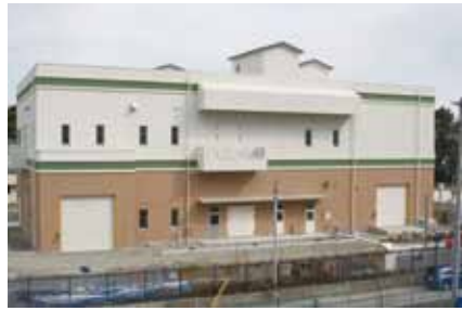
藤倉ポンプ場
