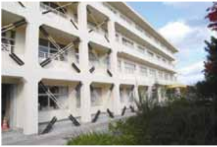
小中学校の耐震補強
