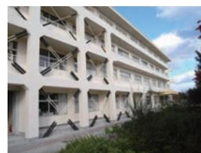
小中学校の耐震補強
